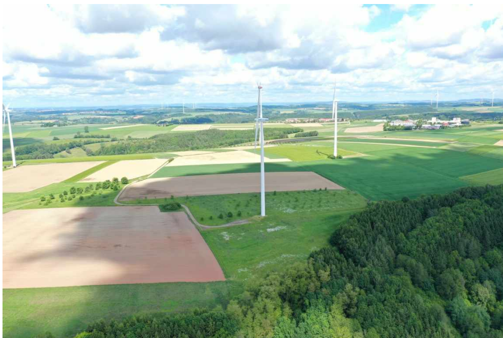
Windpark Weselberg mit den drei zu ersetzenden Bestandsanlagen
