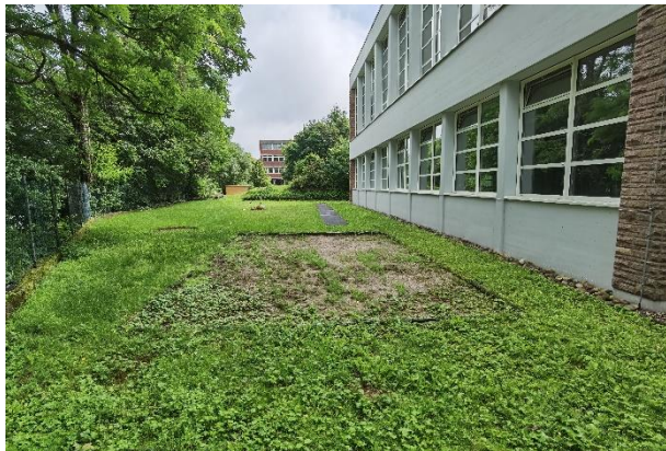
Bild 5: Bereich „alte“ und „neue“ Weitsprunganlage an der Nordseite der Sporthalle
